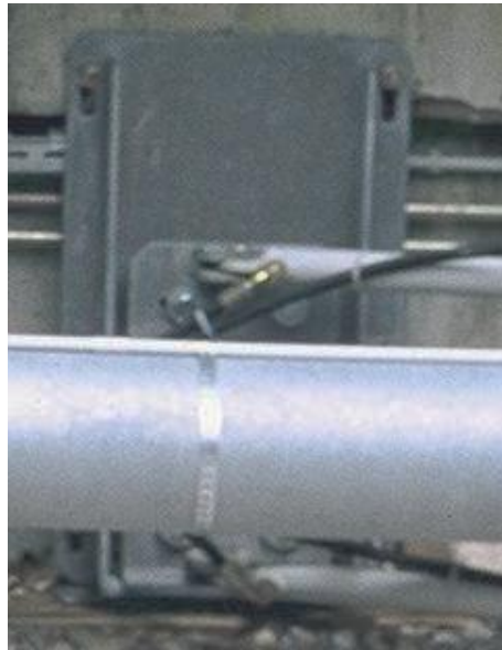
Slika 4.16: Sistem prečnih plošč za vpetje hidravličnih valjev na pomol spodnje postaje
