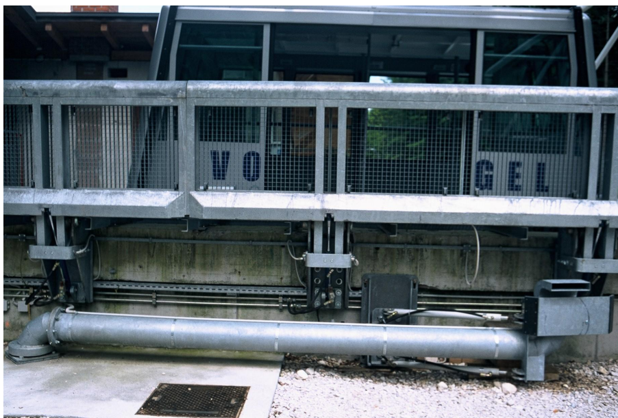
Slika 4.14: Sistem za dotok vode v poliestrski rezervoar na spodnji postaji
