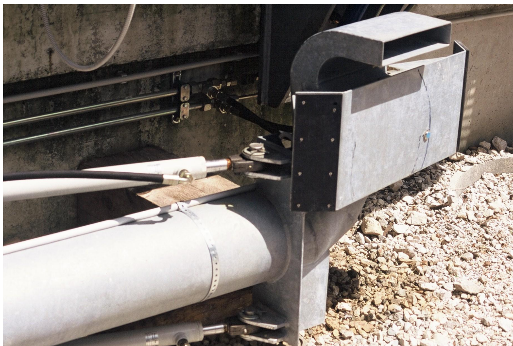
Slika 4.17: Elementi za pozicioniranje in dotok vode na spodnji postaji
