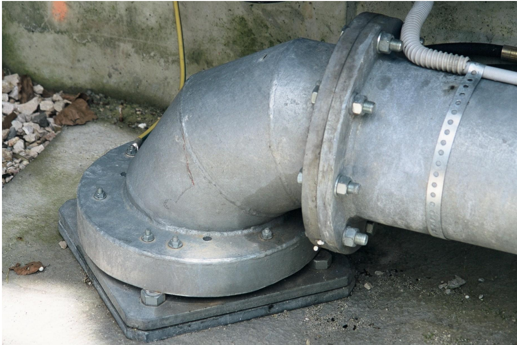
Slika 4.15: Prehod cevi premera \phi 219 mm iz vertikalne v horizontalno lego
