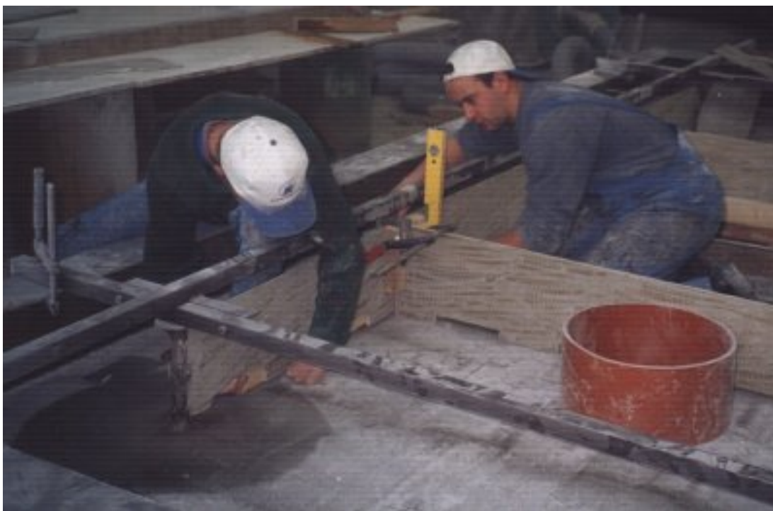
Slika 4.7: Vgradnja ojačitvenih reber in jeklenih puš v rezervoar
